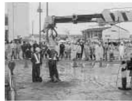
ライフライン応急復旧訓練
