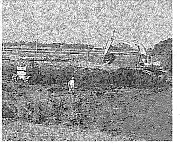
造成工事が着々と進行
