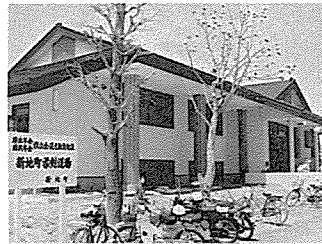
町民柔剣道場の建設には、年金積立還元融資が生かされています。
