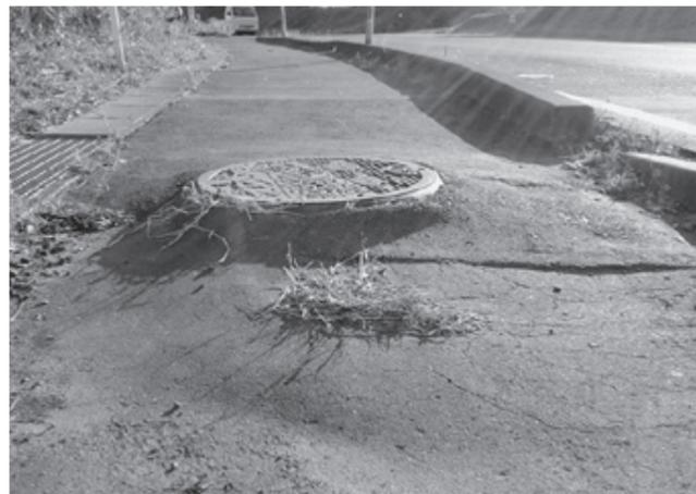
▲周囲が沈下したマンホール
