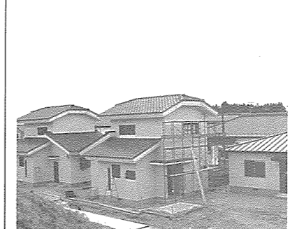
▲ 町営住宅 新林団地
