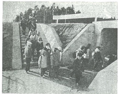
地下道ができて、国道横断の心配がなくなり、学校に通う子どもたちは大喜びです。(国道6号線作田地内)
