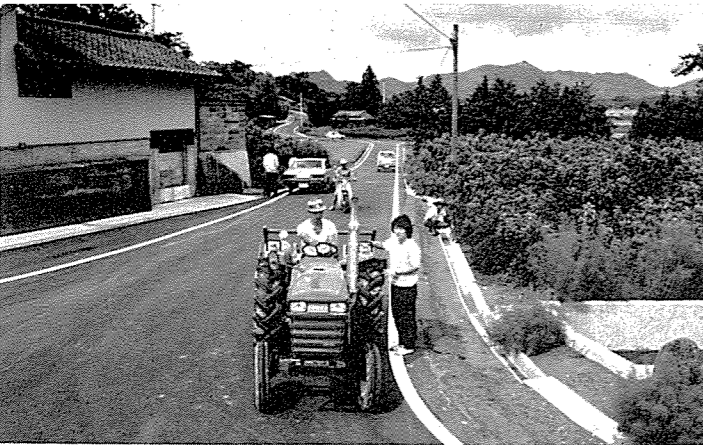
▲59年度舗装整備された浜民駒ヶ嶺停車場線
