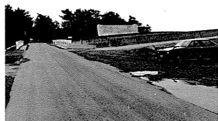
▲主要地方道相馬亘理線整備(釣師・曙橋付近)
