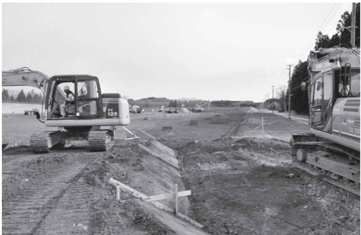
▲急ピッチで工事が進む南工業団地B地区
