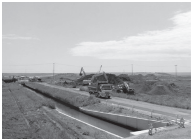
▲JR常磐線東側で行われている農地災害復旧工事
