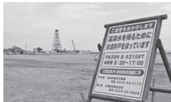
▲新地駅西口で行われている泉源掘削工事
