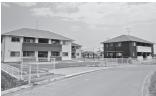
▲12世帯が入居した福田若者定住促進住宅
