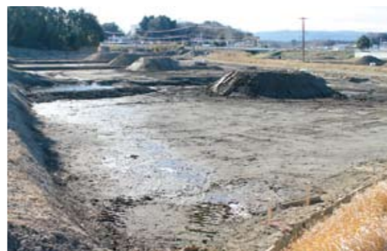
写真 5-25 平成 25 年 5 月 除塩やガレキ撤去を行い復旧
