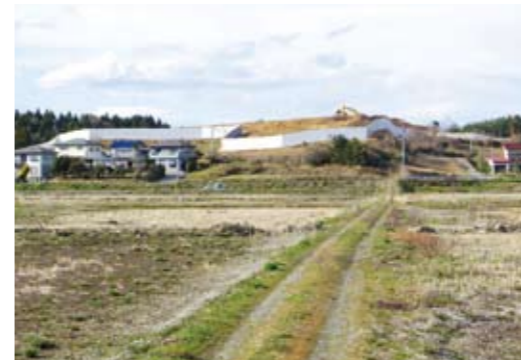
写真5-6 平成25年4月 造成途中
