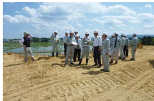
写真 5-33 防災集団移転団地の視察
