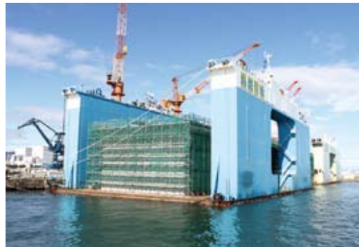
写真 5-20 防波堤再建 (相馬港)
