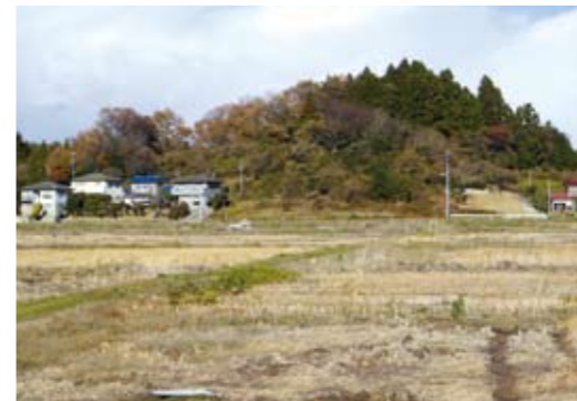
写真5-5 平成24年12月 着工前
