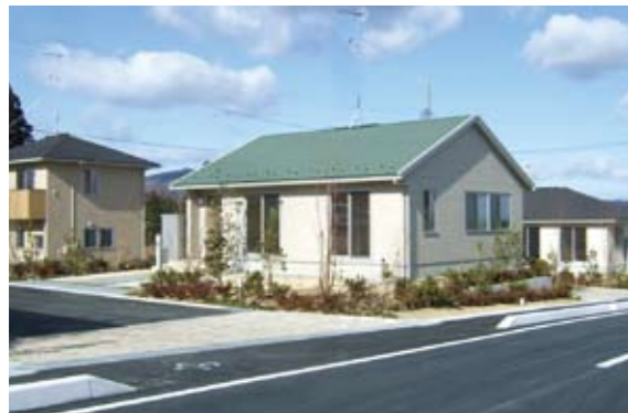
写真 5-12 駒ヶ嶺原災害町営住宅
