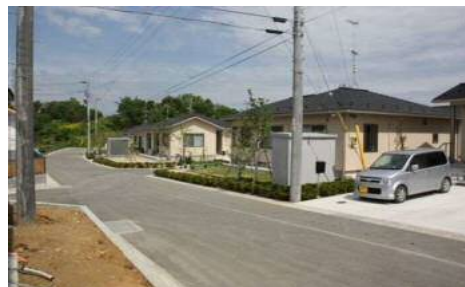
大戸浜町営住宅(11戸)
