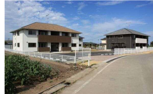
福田定住促進住宅12戸が完成、8/10から入居
