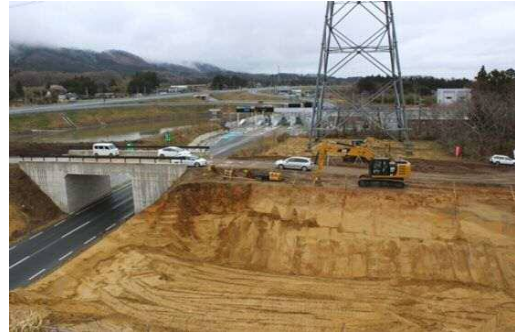
新地インターに建設中の高速バス停留所
