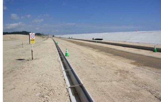
県道：舗装待ちの浜街道(38号線)
