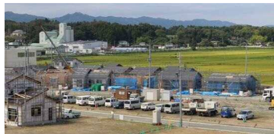
新地駅前町営住宅 26戸建築中(12月完成)
