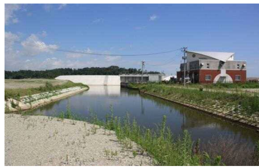
埴浜排水機場の復旧が完了
