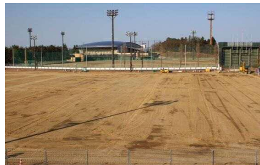
撤去された仮設住宅・総合公園グランド
