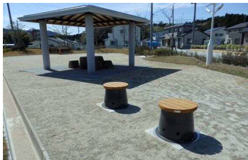
広場に「かまど」ベンチを設置し非常時にも対応
