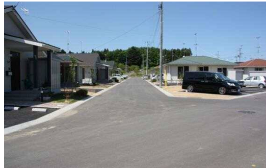
雁小屋町営住宅(27戸)
