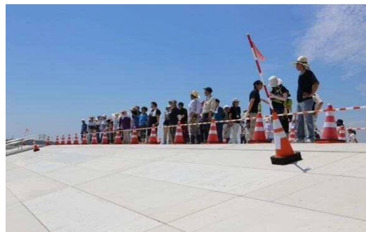
完成した埴浜地区の防潮堤・地区の皆さんと
