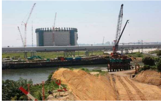
相馬港(町内)に建設中のLNG基地
