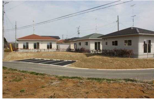
作田東町営住宅(6戸)
