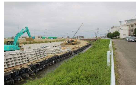
河川：役場裏の砂子田川は区画整理と同時に改修
