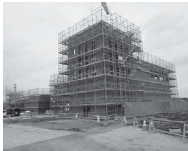
▲建設中の防災センターと消防新地分署
