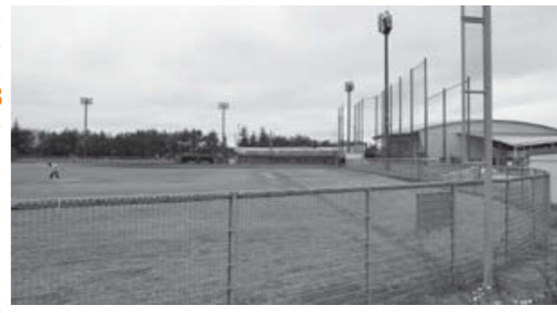
▲改修工事が予定される町民野球場
