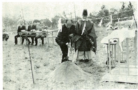
▲ 起工式でくわ入れをする橋本町長
