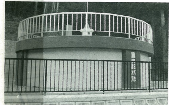
▲沢口地内に完成した第4配水池
