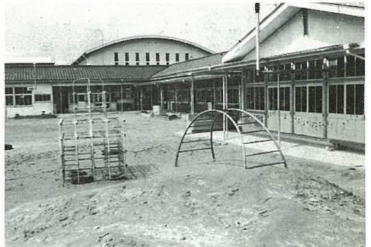
▲鉄筋コンクリートの建物に改築される駒ヶ嶺保育所
