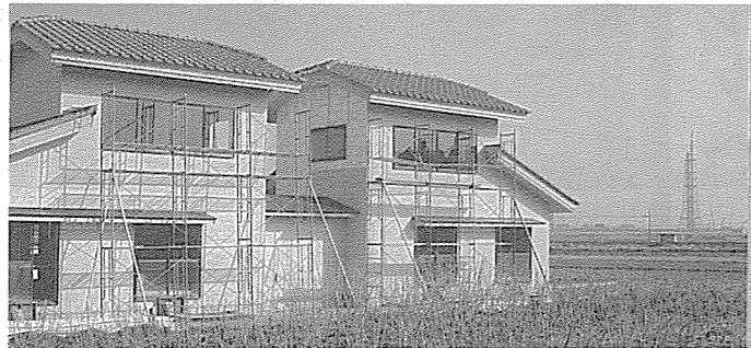
浜民地区に2戸建築中
