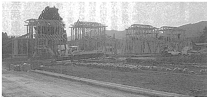
明地区に4戸建築中
