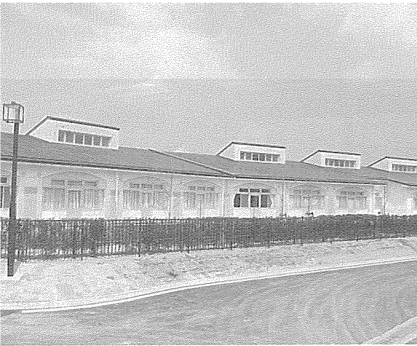
▲ 小川地区に特養ホーム完成
