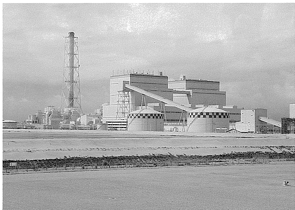
▲相馬港5号ふ頭から新地発電所を望む
