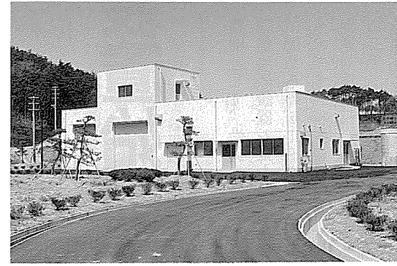
▲1日50トンの浸出水を浄化できる浸出水処理施設
