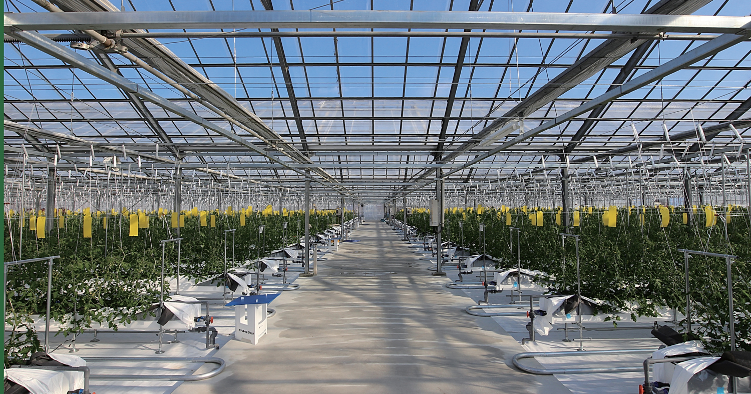
新地アグリグリーンのスィートマシェリハウス内部
