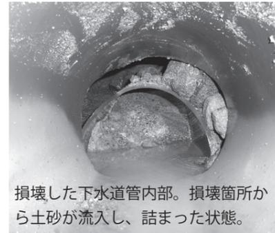
損壊した下水道管内部。損壊箇所から土砂が流入し、詰まった状態。
